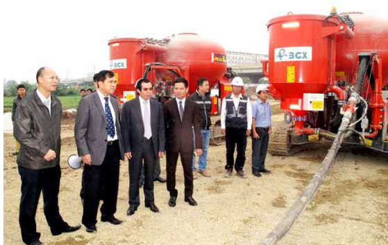
Thứ trưởng Lê Quang Hùng tham quan thử nghiệm công nghệ gia cố nền đất yếu toàn khối nông tại công trường dự án The Manor Central Park tại Hà Nội
