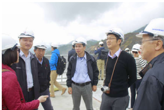
Đoàn công tác Bộ Xây dựng và các chuyên gia JICA khảo sát thi công mặt đập công trình Thủy điện Lai Châu
